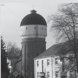
Zu sehen ist hier der Wasserturm in Zossen. Wassertürme dienen der Wasserversorgung von Städten. Der Hochbehälter speichert das Trinkwasser, das auf Grund der erhöhten Lage des Behälters für gleichmäßigen Druck im angeschlossenen Wassernetz sorgt. <
